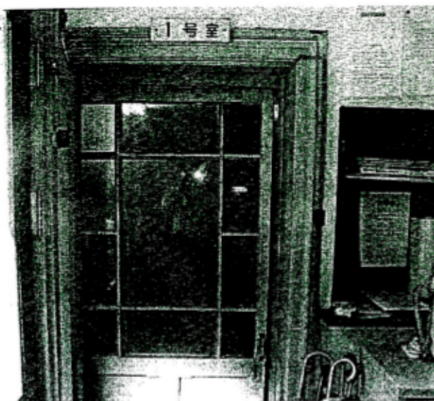
一階入口内部の引込扉
