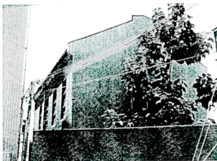
北側背面外観
