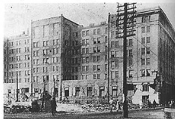
写真2 関東大震災時の円筒式構造の被害例
