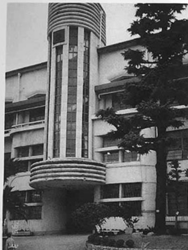
写真1 強かった戦前のRC造建築 灘区魚崎小学校 周囲の戦後のRC造は大被害を受けたのに、戦前の学校校舎が無被害に残った例が至る所で見られた。RC造建築の耐震構造技術が低下して、ついに関東大震災前の水準に戻ったものがあった。
