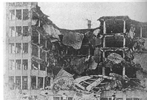
写真2 関東大震災時の円筒式構造の被害例
