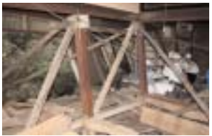
写真―5 ワイヤーの取付け作業
