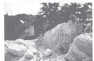
写真3:No.10の造成工事
